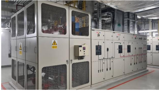
รูปที่ 56 หม้อแปลงไฟฟ้า
