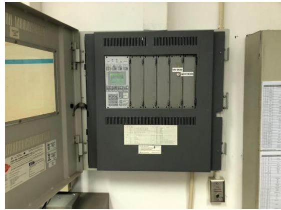
รูปที่ 34 ตู้ควบคุมสัญญาณระบบแจ้งเหตุเพลิงไหม้
