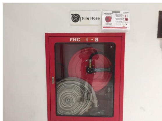
รูปที่ 38 ตู้ดับเพลิง (Fire Hose Cabinet)
