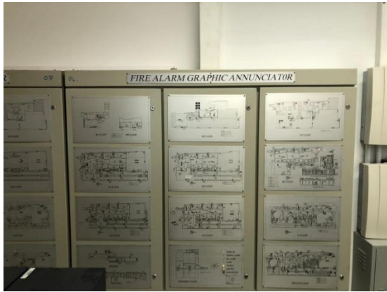
รูปที่ 34 ตู้ควบคุมสัญญาณระบบแจ้งเหตุเพลิงไหม้
